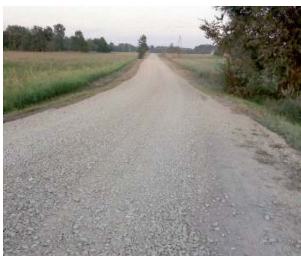
Droga została poszerzona, a pobocza wykoszone
