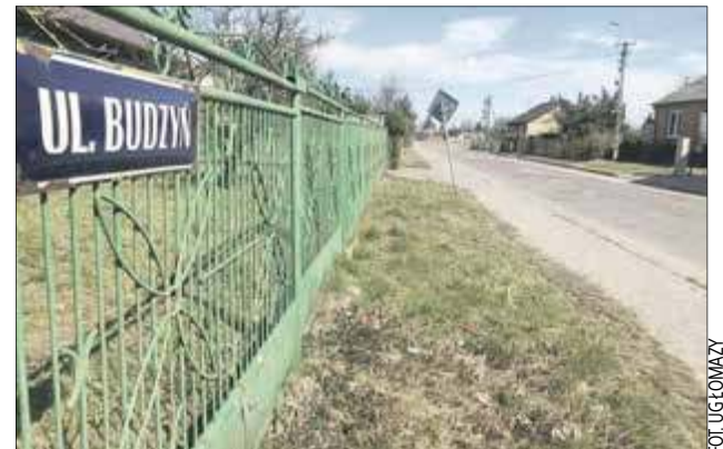
Droga zostanie wyremontowana jeszcze w tym roku
