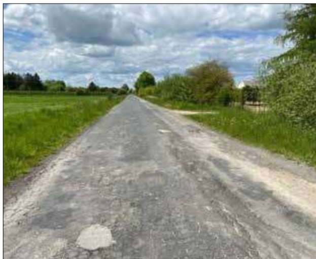
Droga powiatowa do Horodyszcza już w tym roku doczeka się przebudowy. Rząd przyznał powiatowi bialskiemu dotację na tę inwestycję w kwocie ponad 3 mln zł
