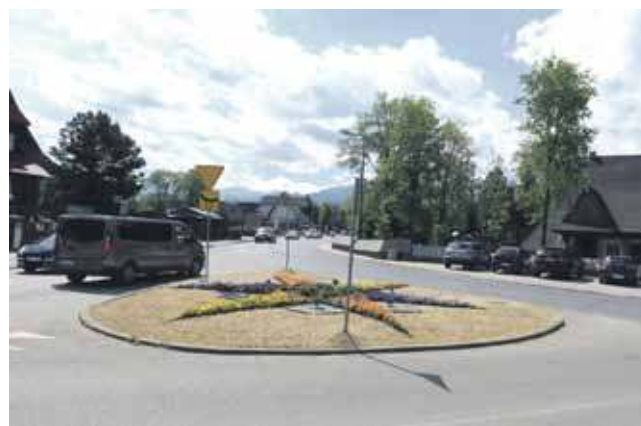
Zamiast traw po pas - klomb przypominający góralską rozetę, tak dziś wygląda skrzyżowanie drogi wojewódzkiej i ulicy Piłsudskiego w Poroninie.
