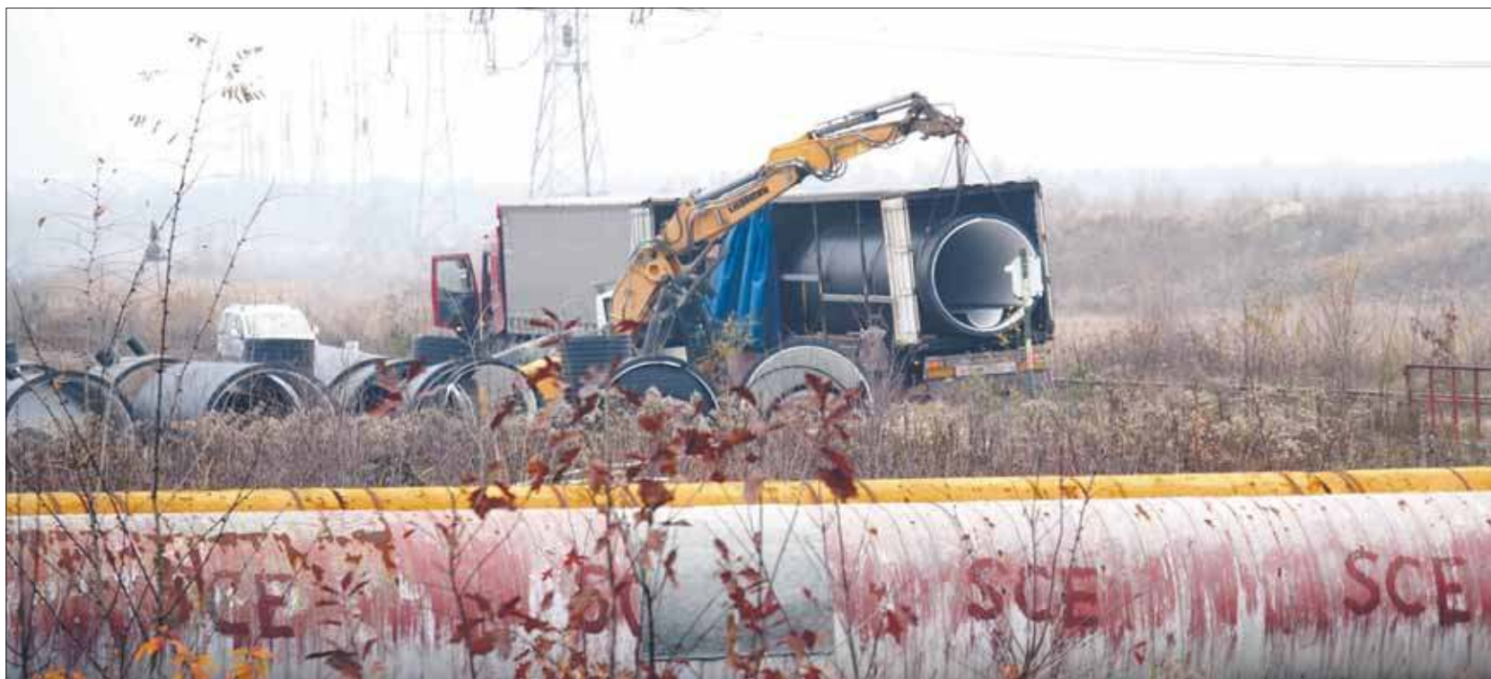
Budowa rurociągu na Izerze
