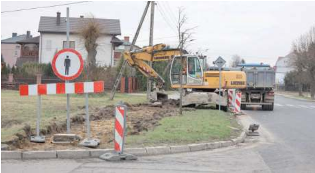
Remont chodnika przy ul. Kopernika
