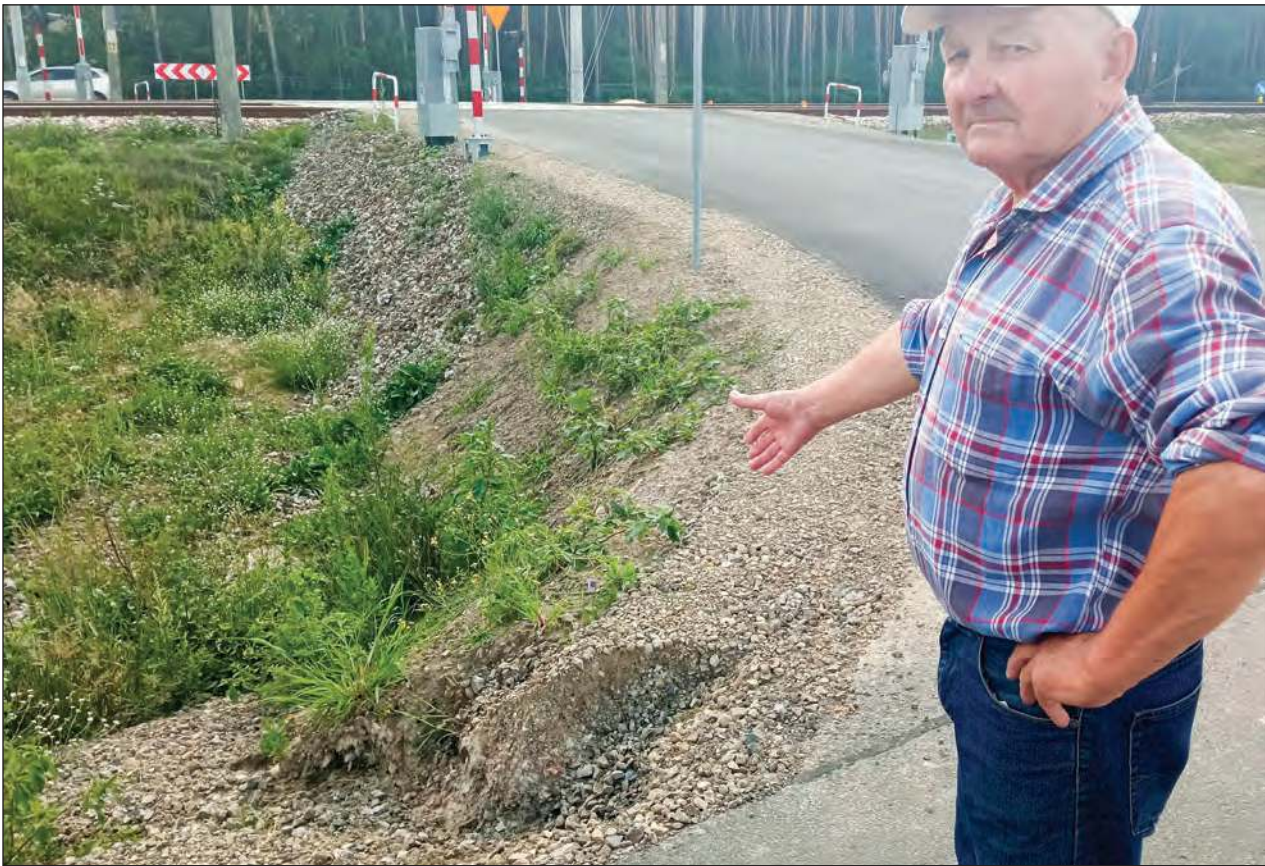
» Józef Wałęka niepokoi się o zerwane przez wodę pobocze. - Może dojść do tragedii - mówi naszej redakcji
