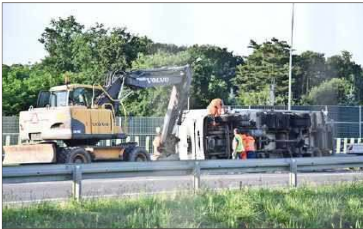
W momencie podnoszenia pojazdu ruch na autostradzie w kierunku Rzeszowa został zamknięty przez policję.
