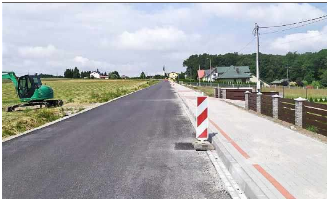
Przebudowa drogi jest już bardzo zaawansowana. Fot. Starostwo Powiatowe w Dębicy.
