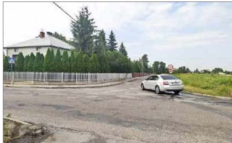
Skrzyżowanie Metalowców i Mościckiego zostanie przebudowane. Niestety wycięte zostaną także drzewa.
