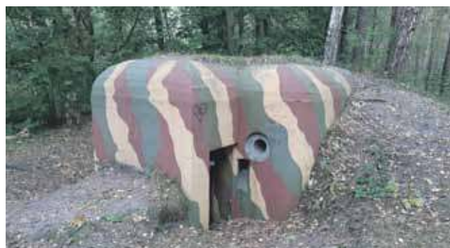
Lekki schron piechoty, jedyny, który zdążyliśmy zbudować we wrześniu 1939 roku z planowanych czterech.
