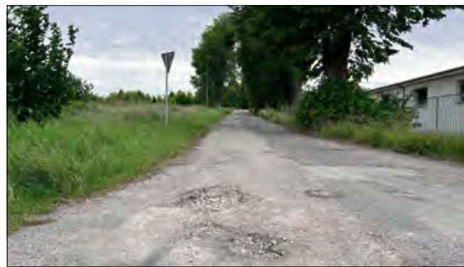
Wykonawcą zadania jest firma z Łędzin.
