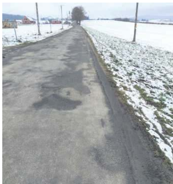
Radni zarezerwowali w budżecie kwotę 90 tys. zł na dokumentację przebudowy kilku dróg powiatowych, m.in. ul. Siemysławicką w Przewornie. Foto: PZD Strzelin
