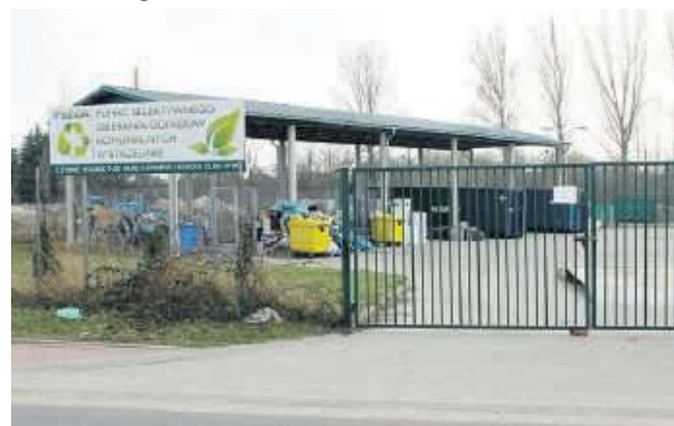
W budżecie gminy Strzelin na 2022 rok znalazła się m.in. modernizacja Punktu Selektywnej Zbiórki Odpadów Komunalnych przy ulicy Glinianej w Strzelinie
