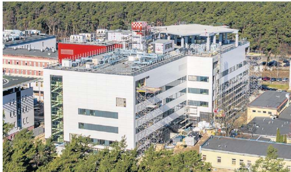
Sercem lecznicy będzie nowoczesny pięciokondygnacyjny budynek. Budowa trwa
