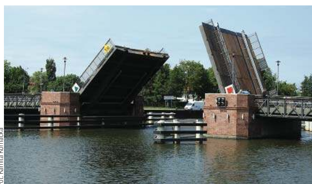
Remont Mostu Dolnego dobiegł końca
