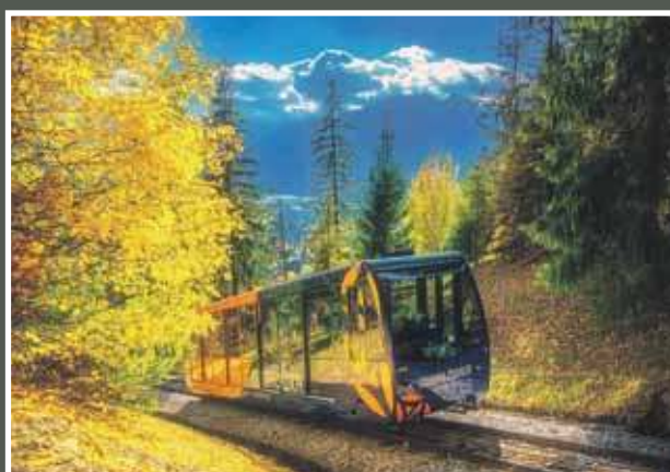
Kolej linowo-terenowa PKL na Gubałówkę
