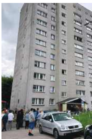
■ Mieszkańców bloku ewakuowano na zewnątrz budynku
