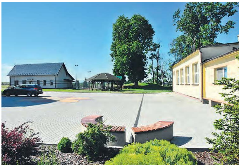
Kamery mają pojawić się m.in. przy świetlicy wiejskiej i klubie seniora w Żalnie. W tym roku miałyby zostać ponadto zainstalowane w Tuchółce i części parku w Kęsowie. Fot. Lucyna Zdanowska
