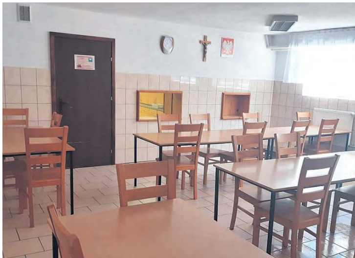
W stołówce wymienione zostaną okna podawcze.
