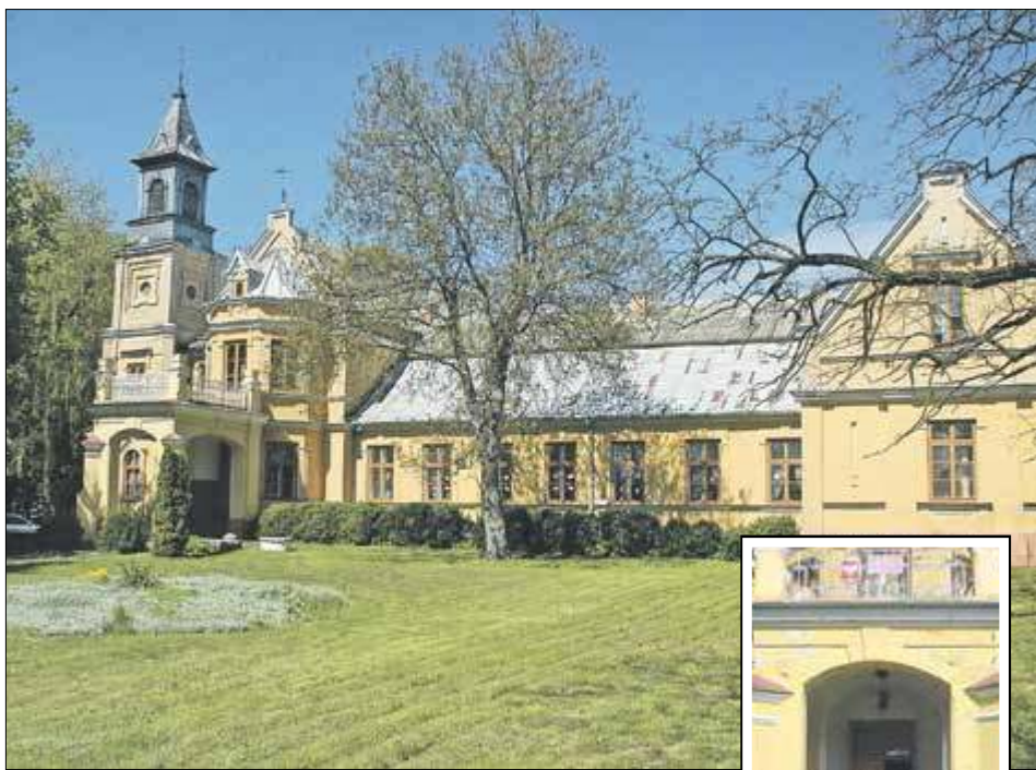
Zabytek jest wyjątkowej urody, niestety nie spełnia wymogów budowlanych, by prowadzić w nim szkołę
