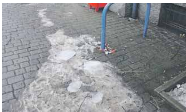
Trzeba było uważać. Na zdjęciu lód, który spadł z dachu budynku poczty
