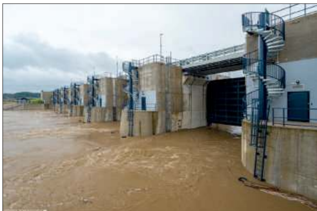
Fotografie przedstawiają budowlę przelewowo-spustową w zaporze czołowej zbiornika w trakcie opuszczania zasuw (zdjęcie z lewej strony, wykonane 14.10.2020 r.) oraz po ich opuszczeniu (zdjęcie po prawej stronie, wykonane 15.10.2020 r.).
