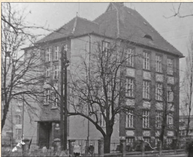
Gmach szkoły przy ulicy Nowotki 10 po rozbudowie
