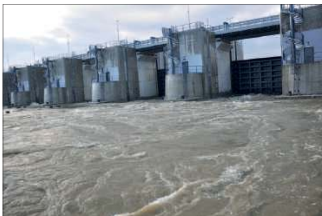
Fotografie przedstawiają budowlę przelewowo-spustową w zaporze czołowej zbiornika w trakcie opuszczania zasuw (zdjęcie z lewej strony, wykonane 14.10.2020 r.) oraz po ich opuszczeniu (zdjęcie po prawej stronie, wykonane 15.10.2020 r.).
