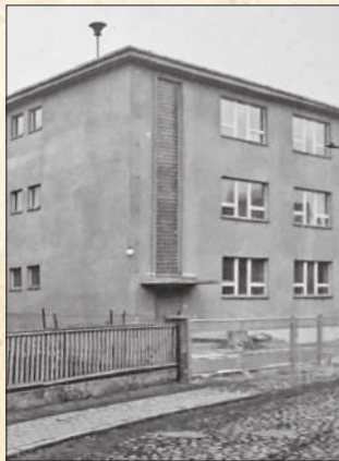
Ten sam budynek po remoncie w 1968 roku
