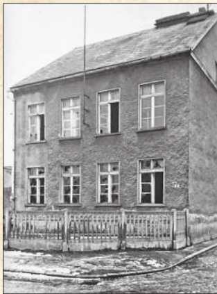
Budynek szkolny przy ulicy Jana 14 w lutym 1964 roku
