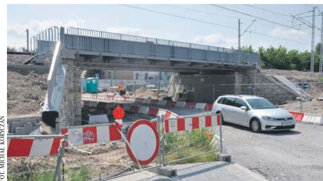
Przejazd tymczasowy pod wiaduktem nad ul. 29 Listopada
