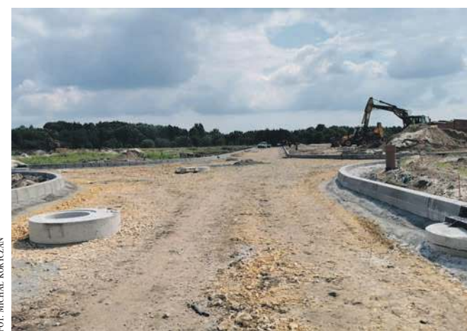
W strefie budowane są drogi i kanalizacja deszczowa
