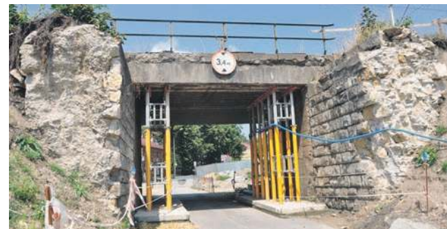
Przebudowa drugiej połowy wiaduktu nad ul. Kadłubek ma się zacząć w czwartym kwartale tego roku
