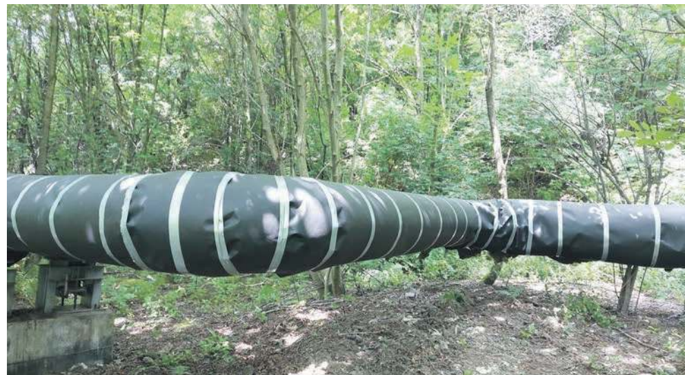
Rura ciepłownicza w rejonie ul. św. Stanisława została zabezpieczona i uszczelniona
