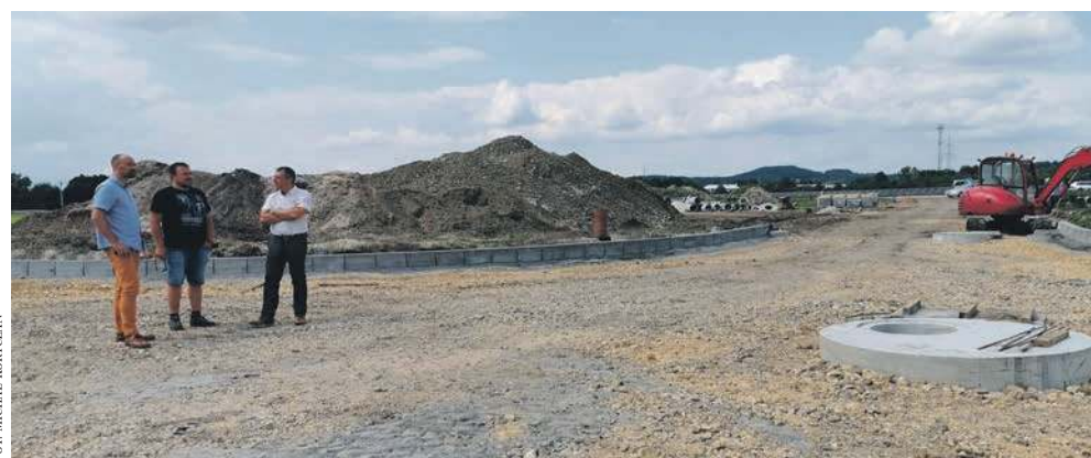
Wójt Radosław Warzecha i jego zastępcę Dawid Pierzchała sprawdzają zaawansowanie robót w strefie
