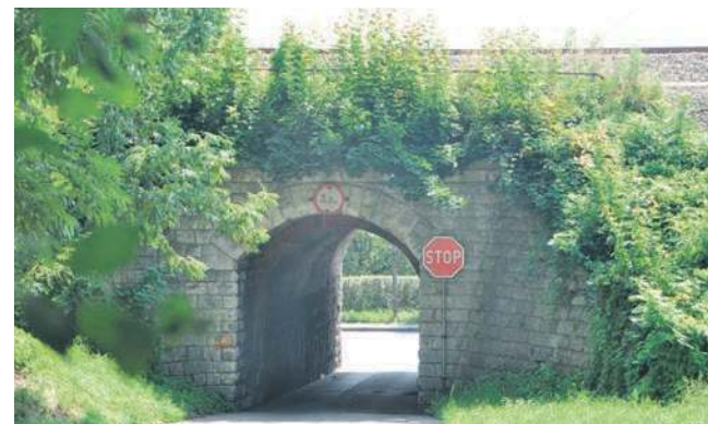
Obiekt nad ul. Krasickiego zostanie wyremontowany
