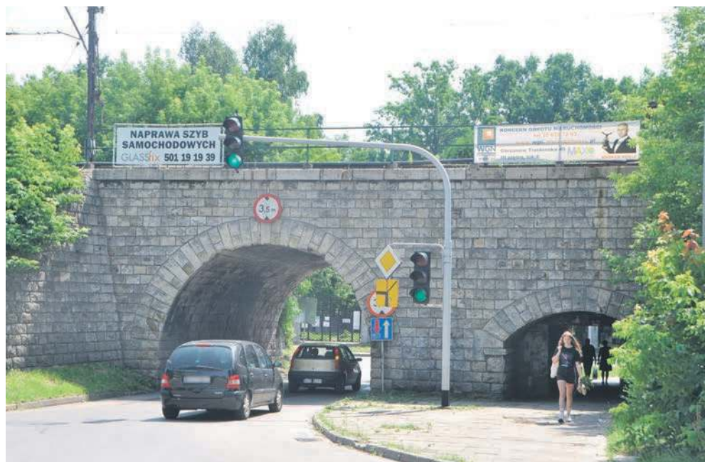
Wiadukt nad ul. Sienną czeka modernizacja
