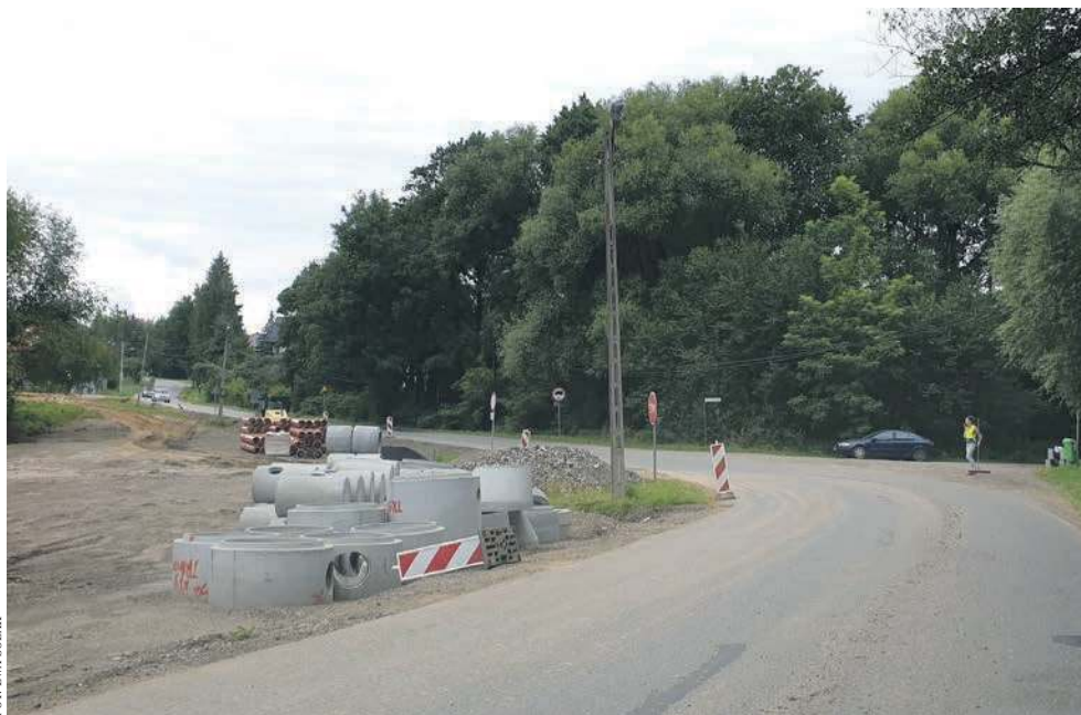
Prace na Dziećmiorgu mają się skończyć przed upływem wakacji
