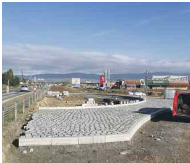
Kostka na połowie ronda już ułożona.
