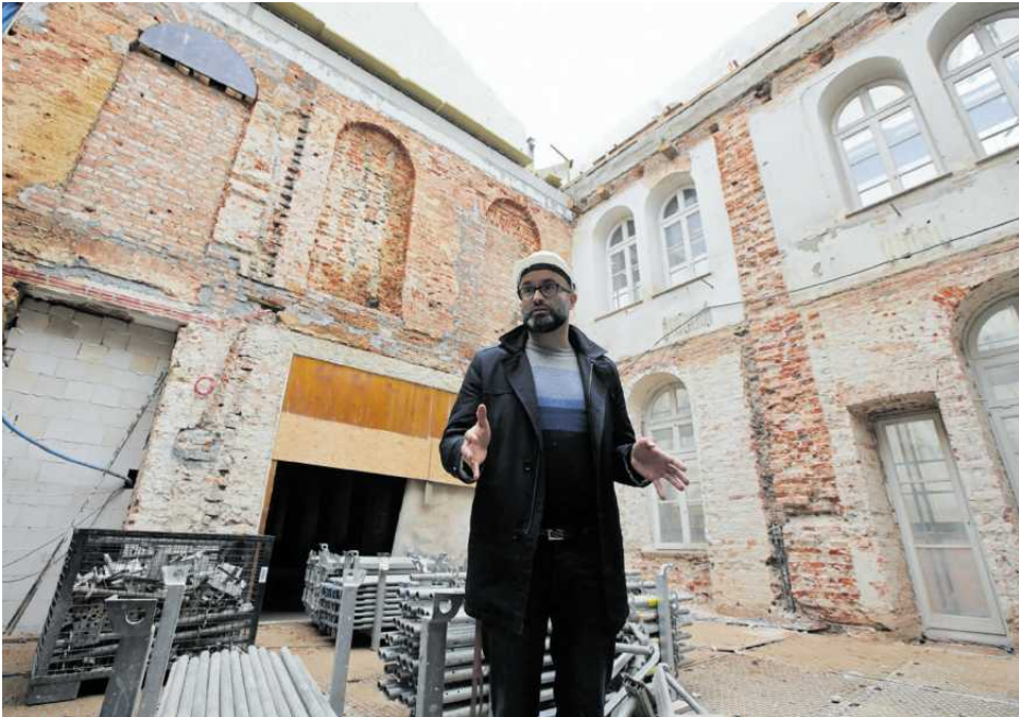
• Kielce, 23 marca 2023 r. Michał Kotański w przebudowywanym Teatrze im. Żeromskiego
