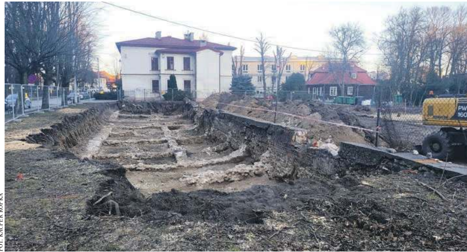
(E) Wykopy przy liceum w Krzeszowicach
