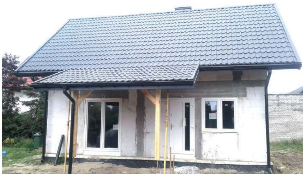
Nowy dom dla rodziny z Wronowa jest już gotowy. Dzięki pomocy ludzi dobrej woli pani Monika i jej bliscy mogli tegoroczne święta spędzić w odbudowanym domu
