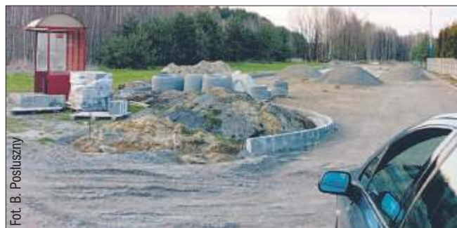
Przy stadionie w Cmolasie budowany jest długo wyczekiwany parking.
