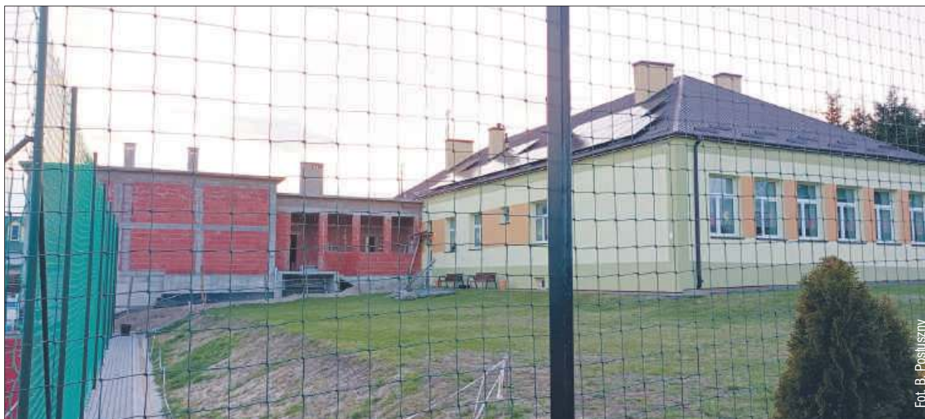
W Hadykowie trwa rozbudowa szkoły.
