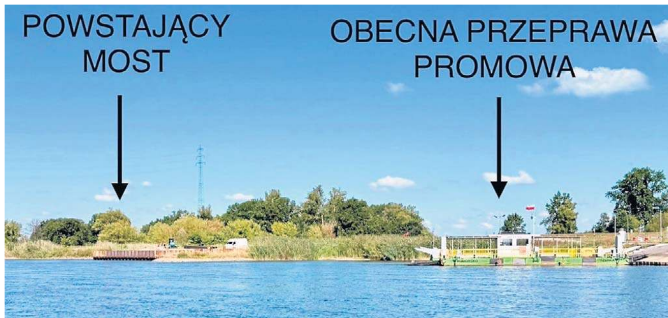
W Lubuskiem budowany jest się kolejny most. Nowa trasa skróci przejazd i sprawi, że prom nie będzie już potrzebny.
