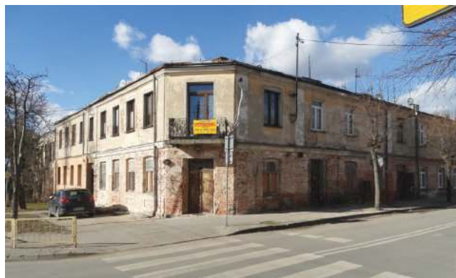
Widok dzisiejszy tego budynku
