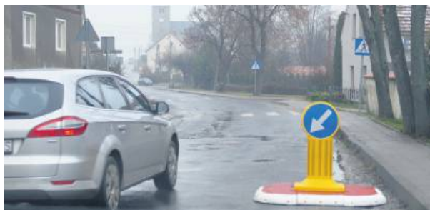
Szykana ustawiona na drodze w Jegłowej przy skrzyżowaniu ulic Skalników z W. Witosą. W tym miejscu kierowcy dużo wcześniej zjeżdżają na lewy pas, aby ominąć nowe oznakowanie, przez co ograniczają widoczność dla nadjeżdżających z naprzeciwka samochodów
