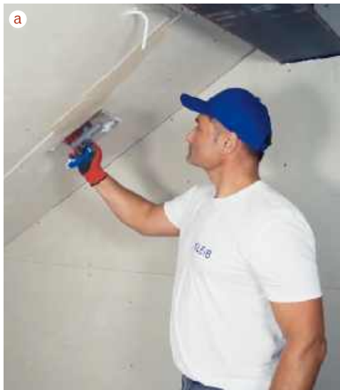
🔧 Łączenia płyt gipsowo-kartonowych zwykle pokrywa się masą szpachlową (a KLEIB) i wzmacnia taśmą (b KNAUF).
