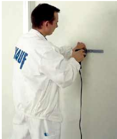
🔧 Suchy tynk z płyt g-k przykleja się do ścian na placki kleju lub mocuje do stelaża wykonanego z profili stalowych lub drewna. KNAUF
