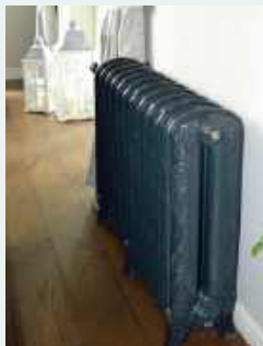
❸ Przy oknie tarasowym, zamontowano ozdobny grzejnik żeliwny na nóżkach.
