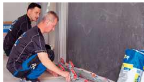
🔧 Układanie wielkoformatowych płytek to dla glazurników spore wyzwanie – przy ich przenoszeniu korzystają ze specjalnych szyn z przyssawkami. KNAUF
