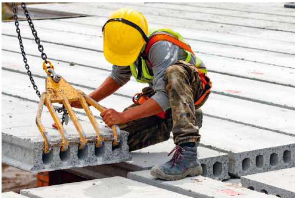
🔧 Wybierając rodzaju stropu trzeba uwzględnić kwestię dostępności elementów oraz łatwość montażu konstrukcji. STROPY.PL
