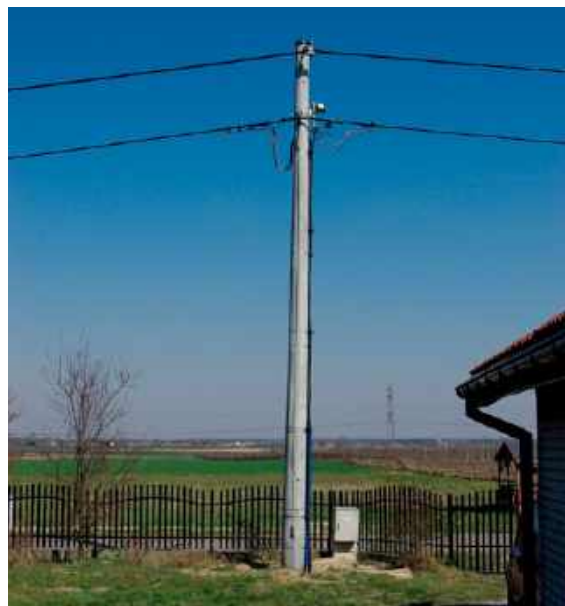
❶ Przyłącze kablowe (ziemne) to obecnie najchętniej wykonywany wariant, nawet gdy linia jest napowietrzna. J. ANTKIEWICZ
