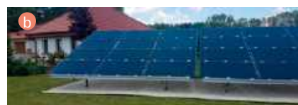
❗ Panele montuje się najczęściej na dachu, stosując specjalny stelaż przymocowany do pokrycia (a BRUK-BET FOTOWOLTAIKA). Gdy na nie ma na nim miejsca lub jest on nieodpowiednio zorientowany, można je ustawić na gruncie, na konstrukcji wsporczej (b HANPLAST ENERGY).
