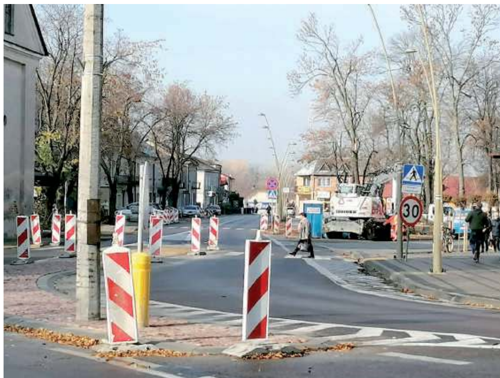
Stary Rynek. Przed 1 listopada ekipa zabrała się za układanie chodnika w pobliżu kościoła. Na czas prac rozstawione zostały słupki drogowe, które stoją cały czas
