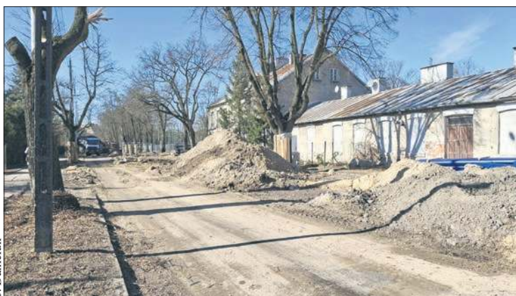
Trwa przebudowa pierwszego fragmentu ulicy Wyszogrodzkiej
