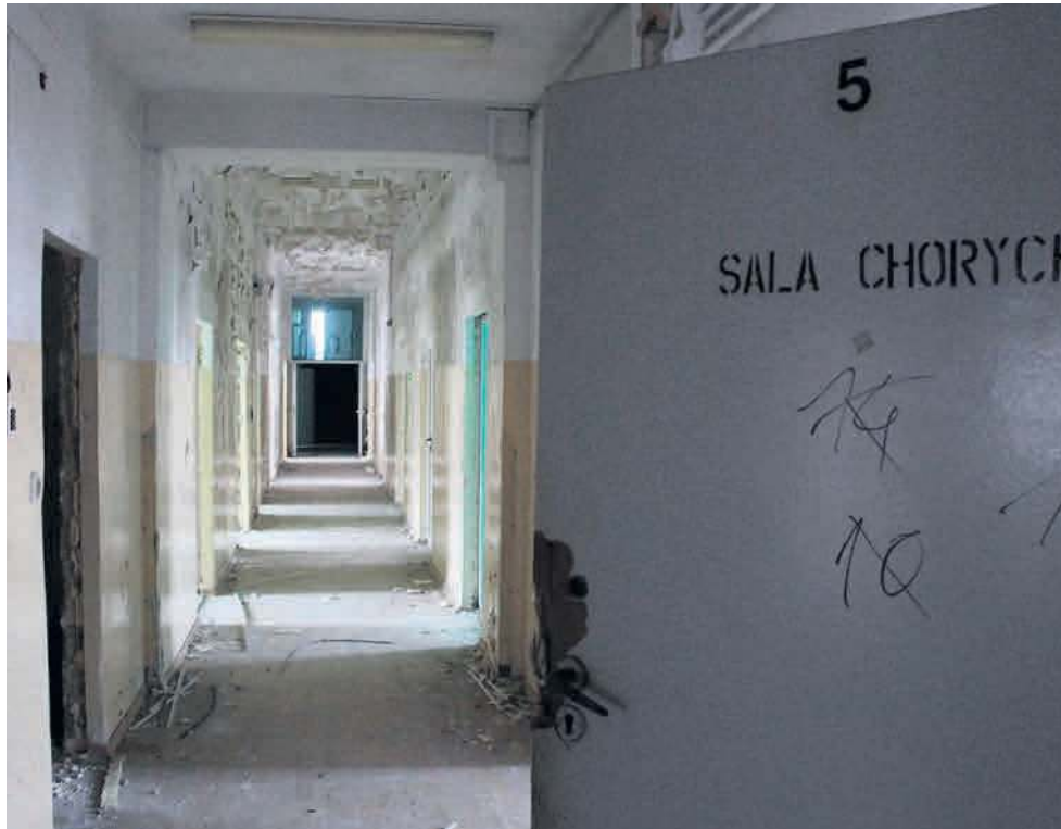
Szpital przy ul. Warszawskiej został zbudowany w 1848 r., został rozbudowany w 1927 r. Pusty stoi od 2007 r. i przez ostatnie lata popadł w ruinę. Więcej zdjęć ze środka na gazetalubuska.pl
