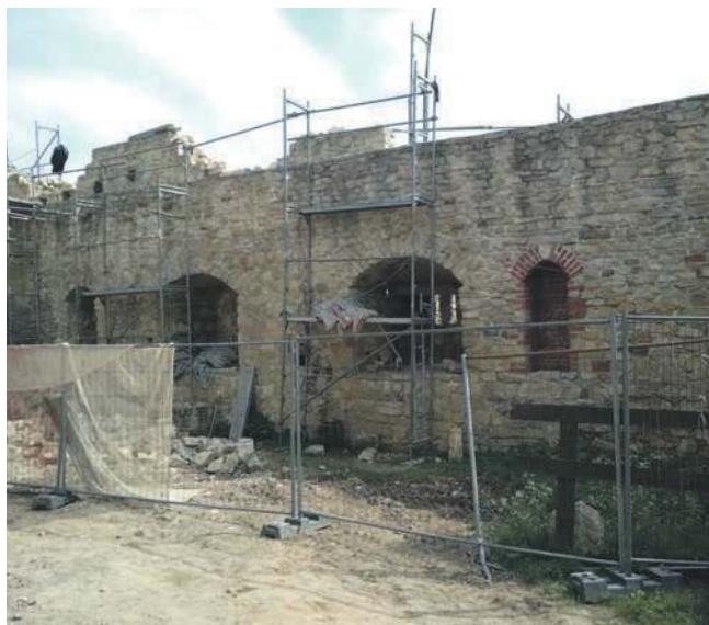
Obecnie trwa remont muru między Bastionem Grunwaldzkim a Basztą Tęczyńską
