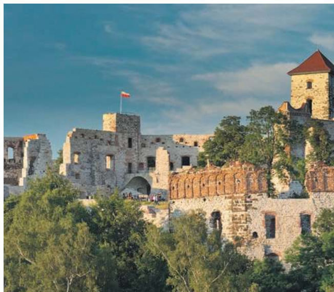
W tym roku ma być zabezpieczona m.in. attyka Bastionu Grunwaldzkiego, widocznego na pierwszym planie
