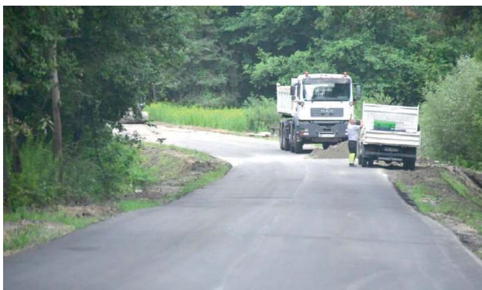
Planowany termin zakończenia inwestycji przebudowy drogi Podsośnina Łukowska - Tarnogród to 23 października 2023 roku
