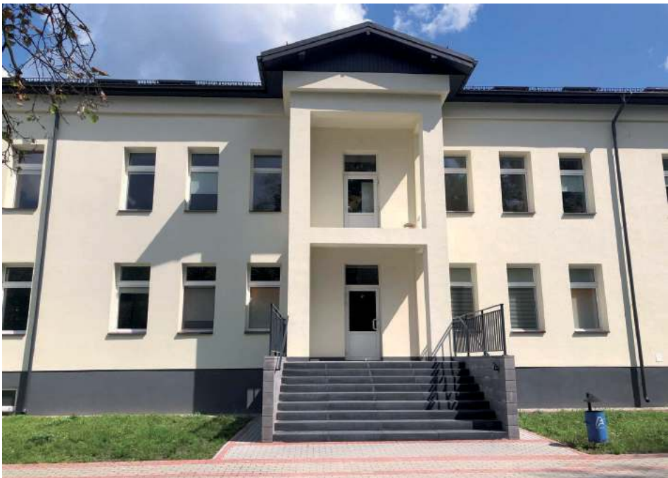
Wyremontowany budynek oddziału zakaźnego biłgorajskiego szpitala
