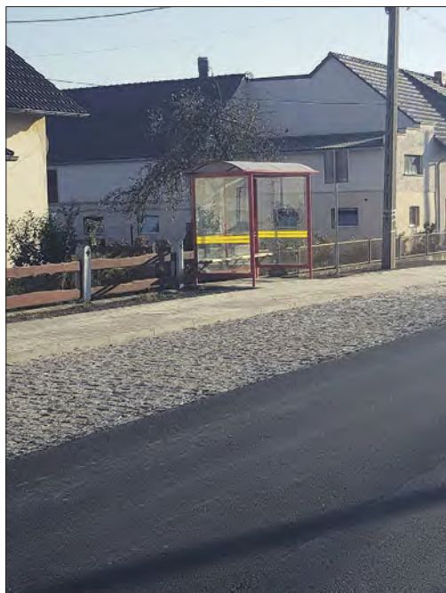
Odcinek drogi powiatowej nr 1209 po remoncie
