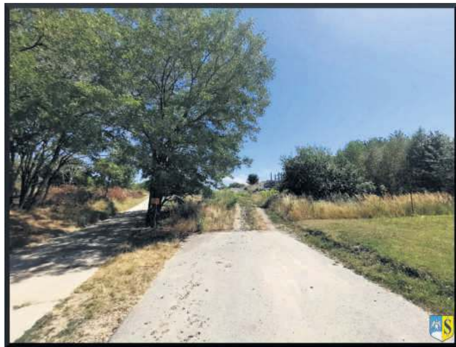
Droga na ulicy Wichrowej w Strzelinie zostanie wytyczona na wprost od miejsca, gdzie obecnie kończy się nawierzchnia asfaltowa. Fot. UMiG Strzelin
