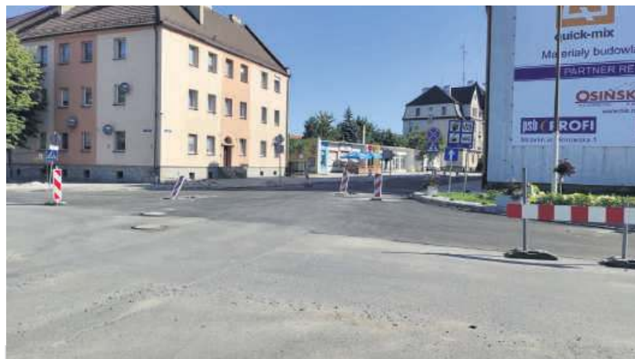
W ubiegłym tygodniu na odcinku drogi od skrzyżowania ulicy Wolności z ulicą A. Mickiewicza do wysokości Delikatesów Centrum położono asfalt
