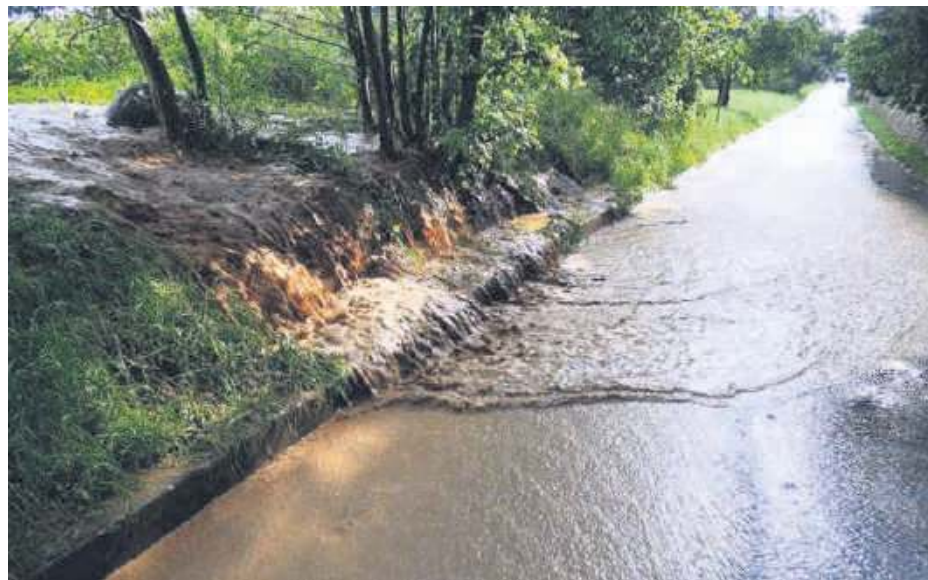
Woda z błotem, spływająca z pól ul. Górzystej, już kilka razy zalewała ulice Strzelina. Problem może rozwiązać tu m.in. wybudowanie odpowiedniej kanalizacji burzowej, która będzie w stanie taki spływ przechwycić i odprowadzić do rzeki
