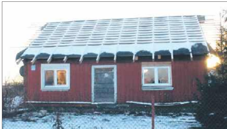
W remontowanym domu brakuje jeszcze całego wyposażenia
