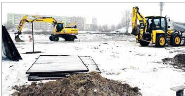
Pierwsze prace przy budowie mieszkań już ruszyły. Zakończenie budowy planowane jest na 2018 rok
