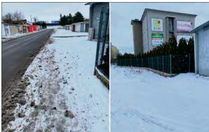
Mieszkańcom brakuje chodnika oraz przejścia dla pieszych w rejonie żłobka „Świat do 3 lat” w Krapkowicach.
