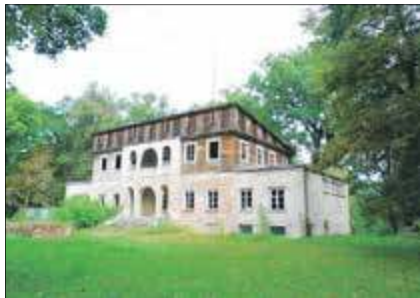
Dzięki pieniądzą z budżetu Mazowsza zaplanowano również prace remontowo-konserwatorskie oraz roboty budowlane przy zabytkowym budynku pałacu w Mężeninie
