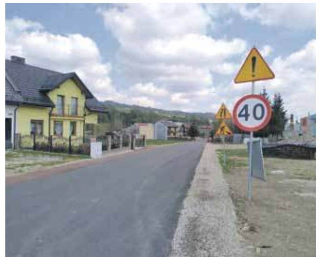
Mieszkańcy mają nowe drogi i rozbudowaną sieć gazową.
