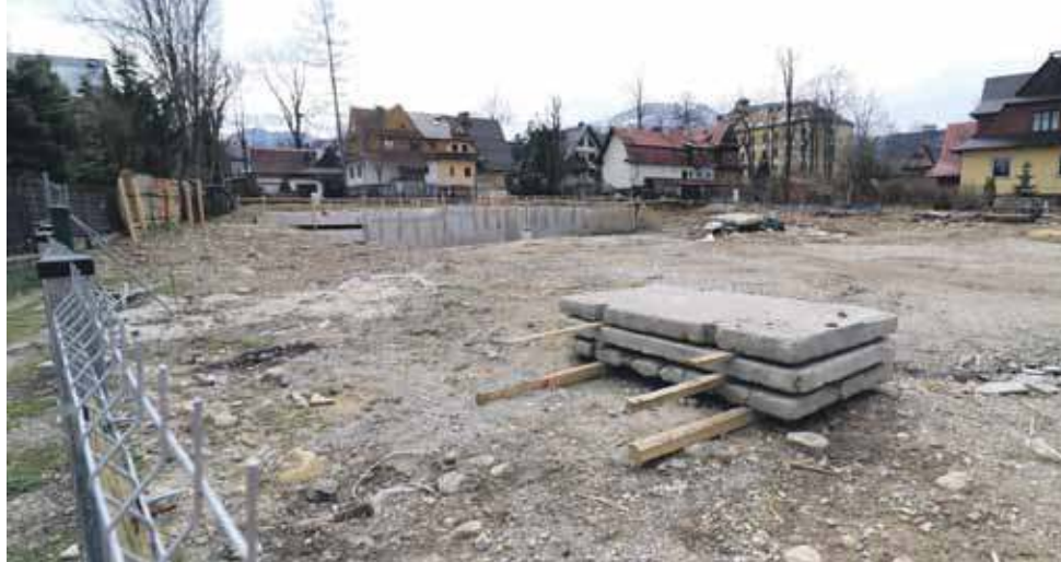
Plac budowy na Chramcówkach. Po wyroku sądu nadzór budowlany wstrzymał prace.
