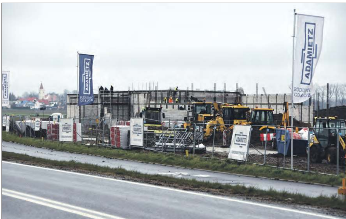
Pierwszy z budynków w centrum handlowym w Lubrzy, którego bryłę już widać.
