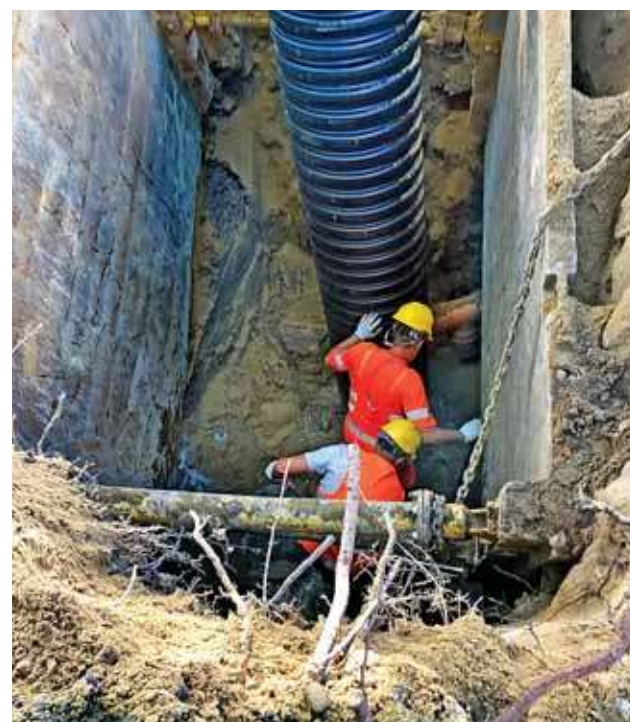
Budowa sieci kanalizacji sanitarnej
