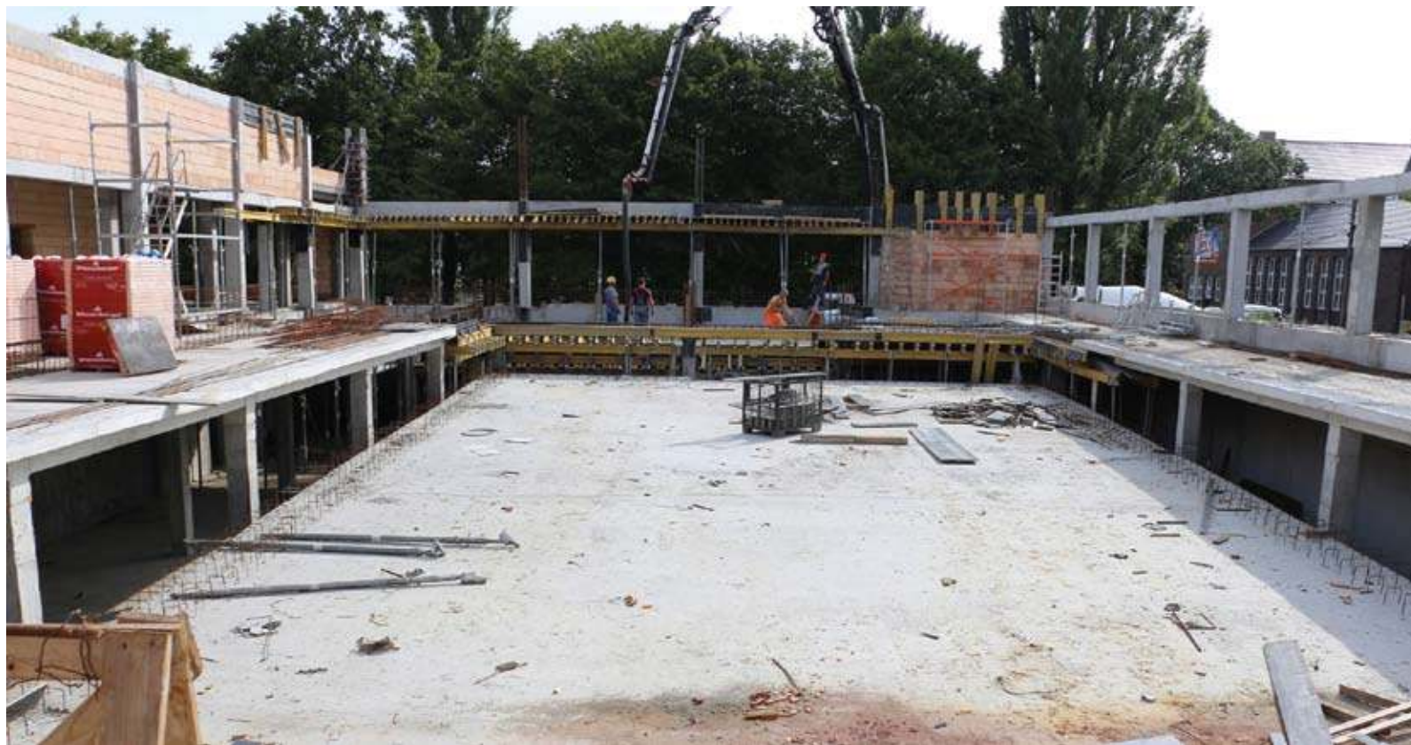
Niecka basenu – serce przyszłej pływalni powoli nabiera swoich kształtów
