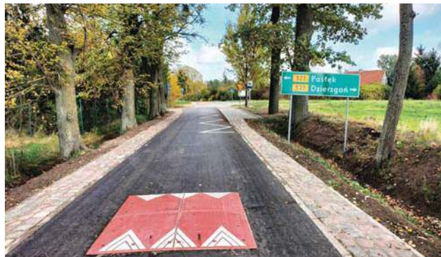
W gminie powstało ponad 12 km nowych odcinków dróg
