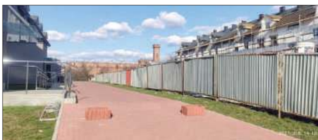
Donice, które blokują dojazd samochodów do klatek schodowych. W ten sposób MZB rozwiązał problem kierowców parkujących auta na ciągu dla pieszych. Jednak jednocześnie utrudniono też dojazd służbom ratunkowym.
