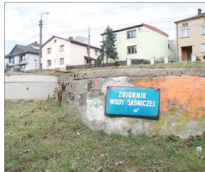
To widok, który zaniepokoił mieszkańców. Po lewej znajduje się kolektor ściekowy, po prawej studnia
