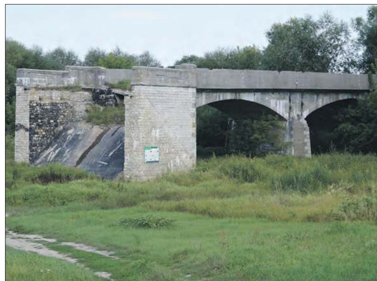
Zachowany fragment betonowego mostu, dzięki któremu Sowieci udało się przekroczyć Odrę
