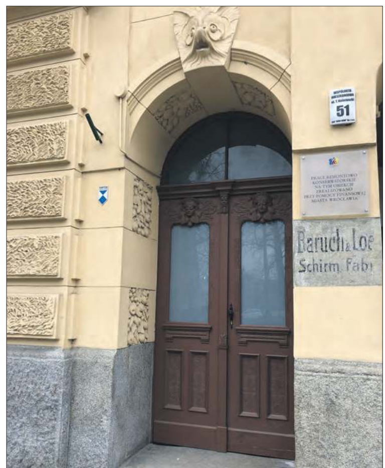
Kolejna wrocławska kamienica z zachowanym napisem. Budynek należy do wspólnoty mieszkaniowej a prace remontowo-konserwatorskie zostały zrealizowane przy pomocy finansowej miejskiego samorządu.
