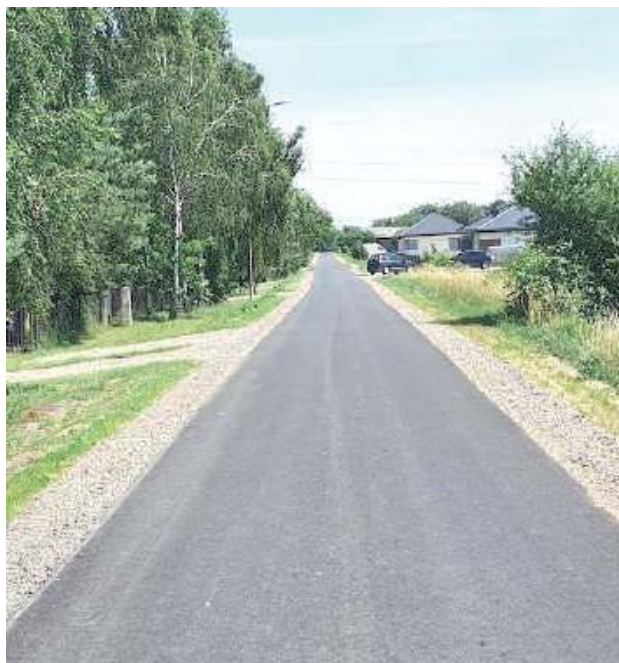
Prace budowlane obejmowały m.in.: wykonanie nawierzchni z betonu asfaltowego, wykonanie warstwy wiążącej, wykonanie poboczy z kruszywa mineralnego, przebudowa istniejących zjazdów
