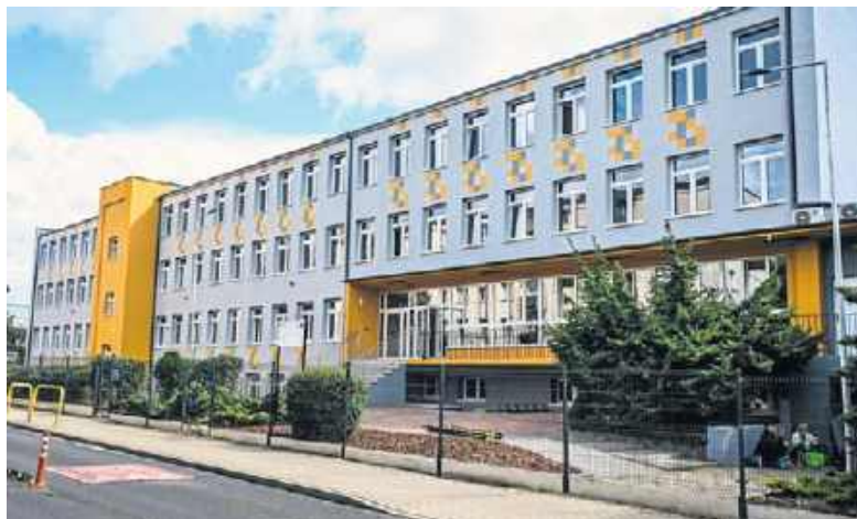
Budynek Zespołu Szkół Ekonomiczno-Administracyjnych przy ul. Gajowej 98 przeszedł kompleksową termomodernizację
