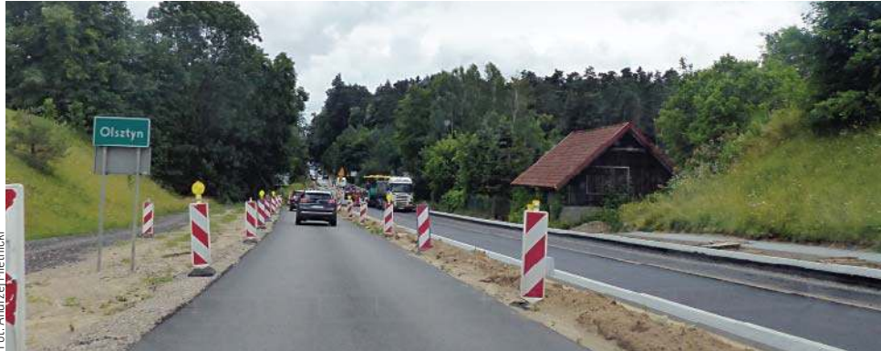
Budowa obwodnicy Olsztyna i Dywit zakłada też przebudowę drogi 51 przez Las Miejski
