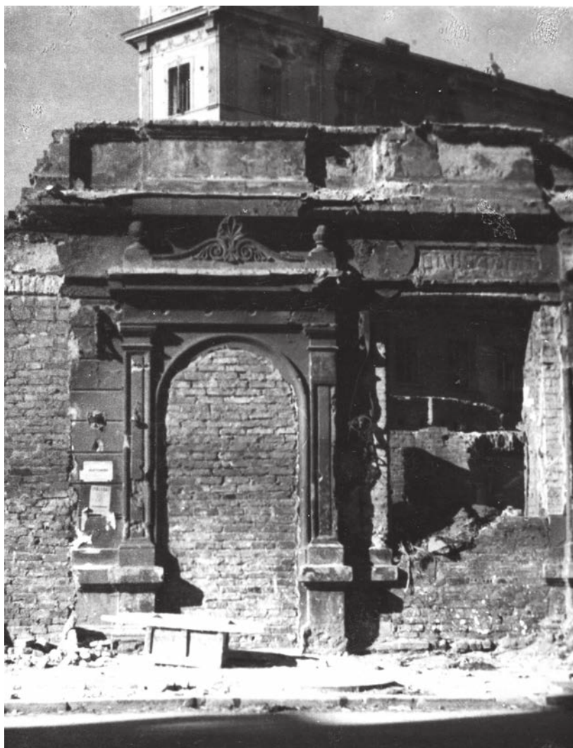
Ogryzek narożnej kamienicy przy Szpitalnej 1, 1945, źródło: Fotopolska
