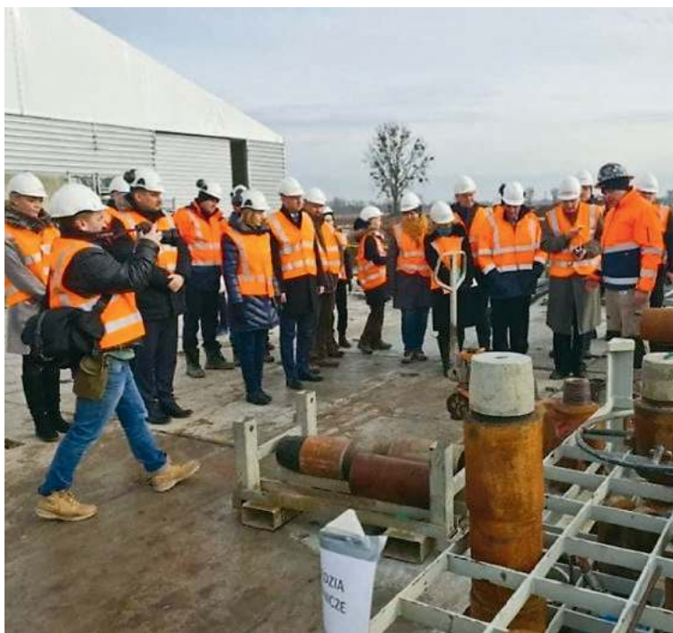
Gazociąg Brzeg-Zębice-Kielczów zamyka korytarz gazowy Północ-Południe na odcinku dolnośląskim | fot. Duw.pl/d
